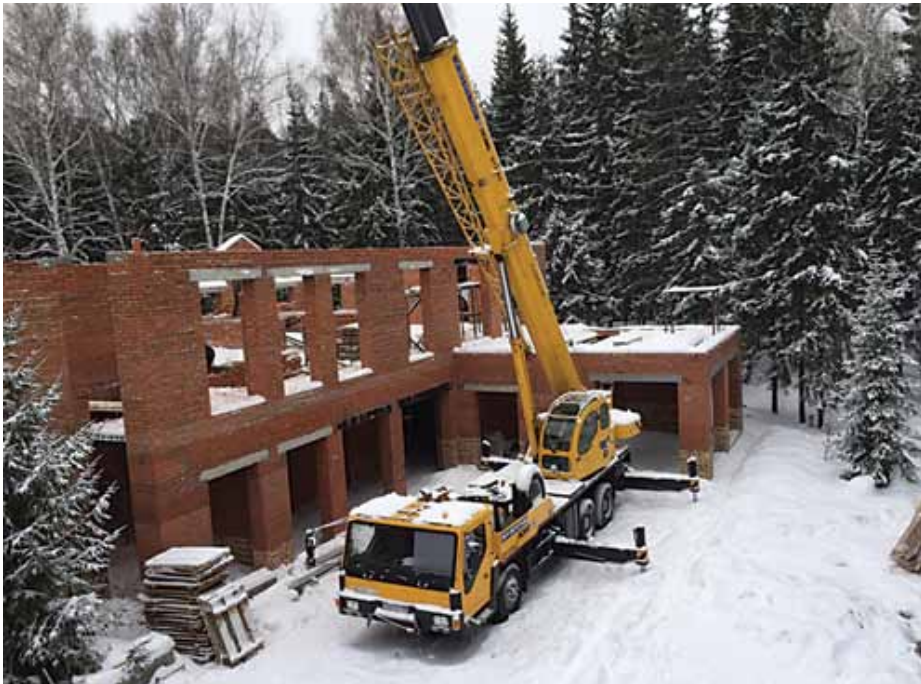
Pakkasista huolimatta uusi saattohoitokodin rakennus on nousemassa
